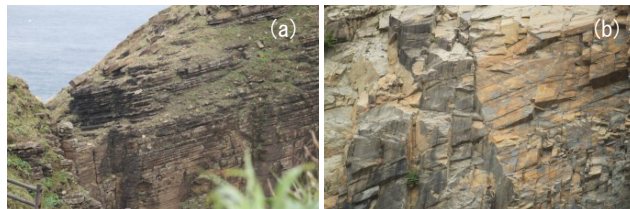
写真8 岩盤露頭の様子。(a)はブロック構造を有する岩盤の露頭、(b)は微細な潜在亀裂を有する岩盤露頭
